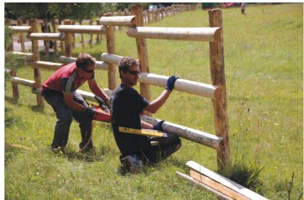
Abb. 3: An die langlebigen Robinienpfosten werden Fichtenquerlatten genagelt.
