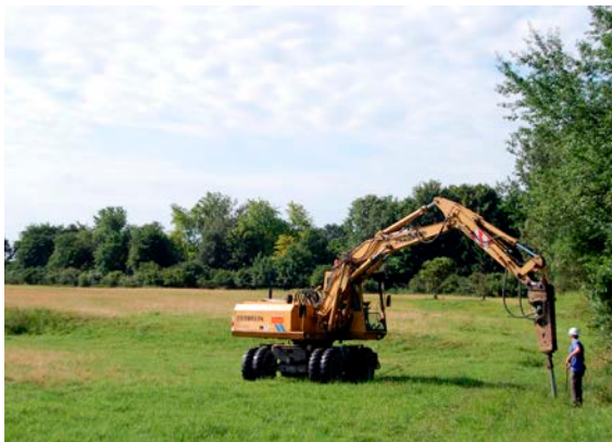
Abb. 2: Mit einem speziellen „Schlacke-Meißel“ werden die Pfostenlöcher in den kiesigen und sehr festen Untergrund gerammt. Dieses Verfahren wurde von den vom LPVA beauftragten Landwirten entwickelt und ist sehr effektiv.
