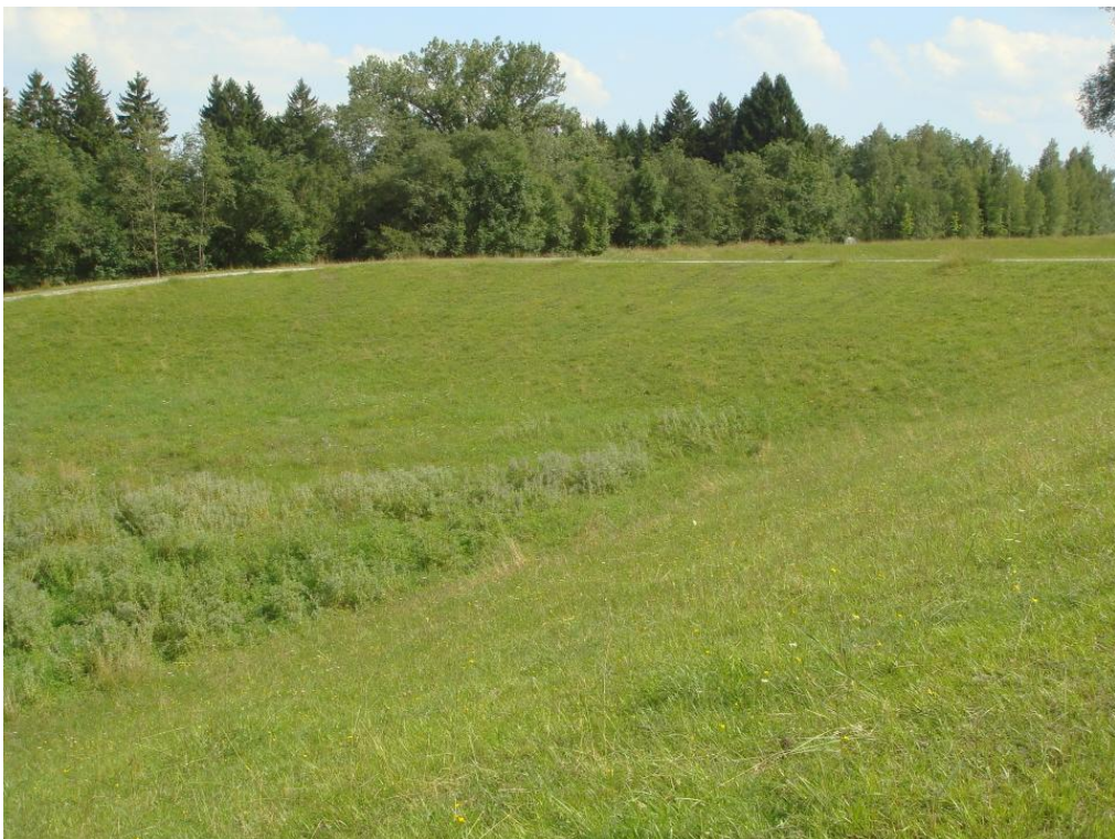
Foto 18 Lechdamm am Ostufer, Blickrichtung Südost, 06.08.2014 Böschung mit Magerrasen neben verbrachter Senke mit Staudenbewuchs
