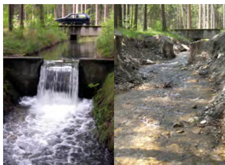
Umbau einer Sohlschwelle in eine Raue Rampe
