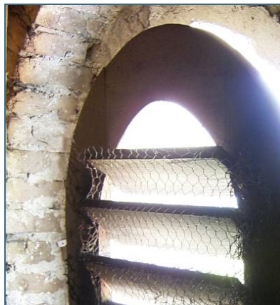
Abb. 17: Damit Fledermäuse gefahrlos einfliegen können, sollte das Taubengitter am oberen Rand der Fensteröffnung weggebogen werden.
