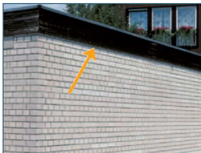
Abb. 4: Wochenstubenquartier von Zwergfledermäusen unter einer Garagenverkleidung.
