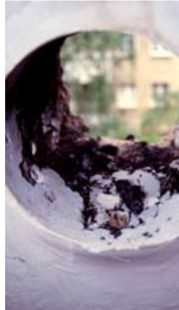
Öffnung von Gasaußenwandheizer mit Fledermauskot © NABU-Archiv
